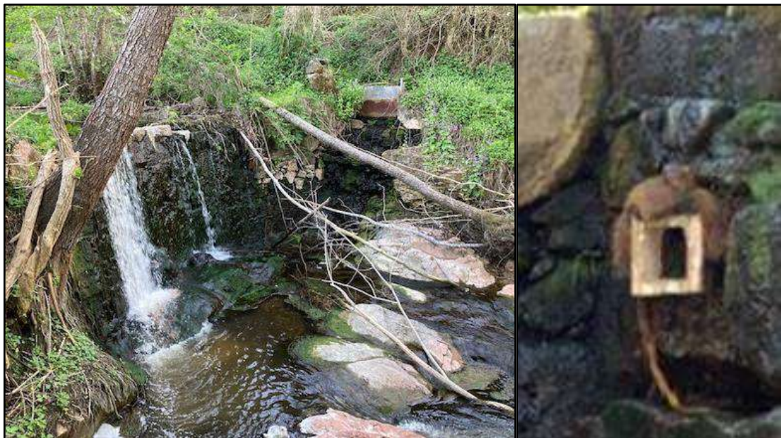
Figura 32. Resclosa grossa de la Cantina (Font: pròpia).
