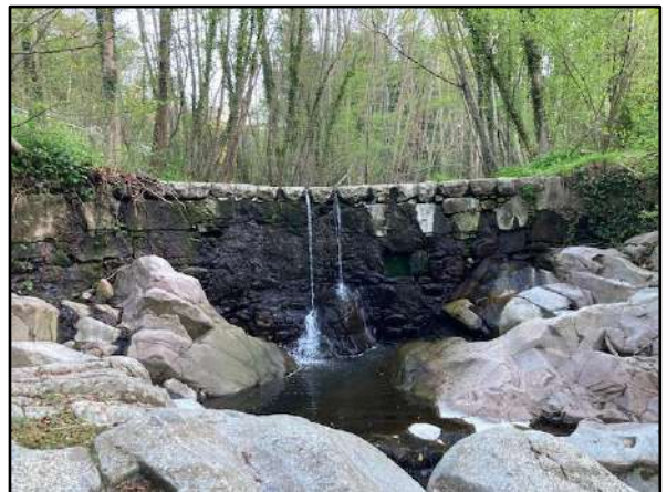
Figura A.4.10. Resclosa entra la Barita i la Gasolinera (Font: pròpia).
