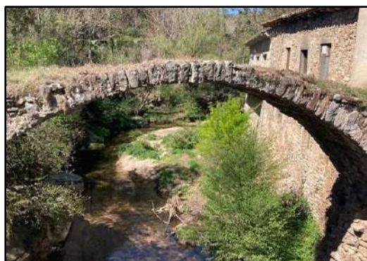
Figura A.4.18. Pont de Bojons. (Font: pròpia).
