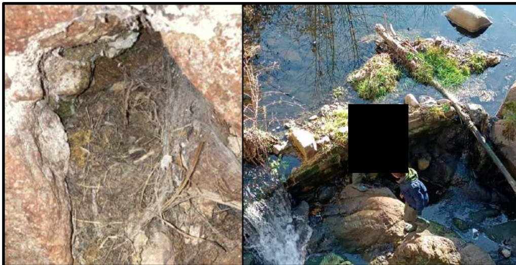
Figura A.4.17. Pont de la Cantina i Resclosa petita (Font: pròpia).
