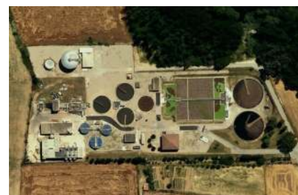
Figura 16: Imatge aèria de la depuradora de Cornellà del Terri.
