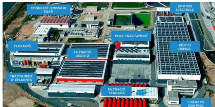
Figura 20: Zona de dessalinització del Baix Llobregat, la principal de tot Catalunya.
