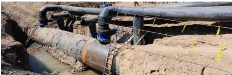
Figura 11: Bomba d'extracció d'aigua subterrània.
