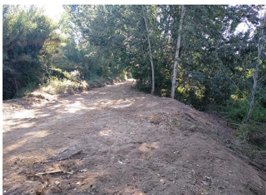
Figura 63. Bosc de ribera afectat per unes obres en època de nidificació a l'itinerari B4_LB11 del riu Tenes.
