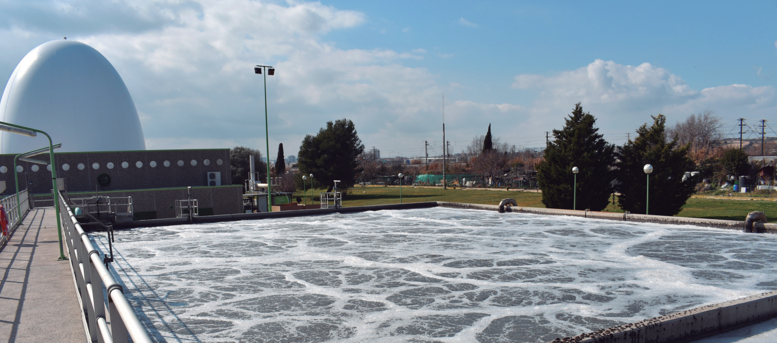
Reactor biològic de l'EDAR la Llagosta.
